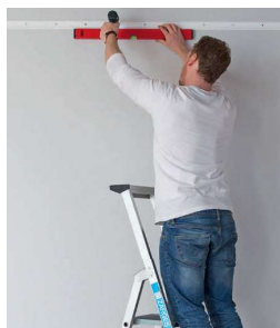
Przykręć szynę poziomą do ściany.
