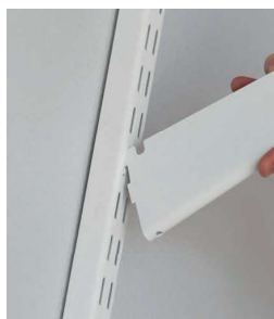
Zamontuj wsporniki w odpowiednich miejscach.
